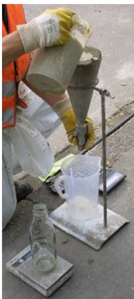
Abbildung 2: Befüllung des Marshtrichters auf der Baustelle
